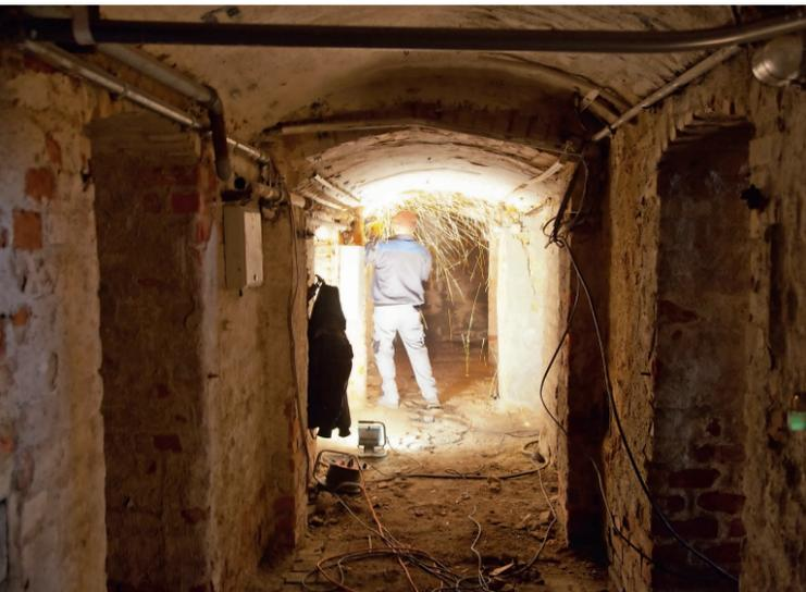
**Abbruch eines Hauses im Leipziger Osten: Das Stahlrohr, das beim Abbruch aus der Kellerwand geschnitten wird, lässt sich einschmelzen und erneut als Baustahl verwenden.**
